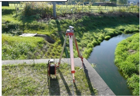
氾濫危険箇所 監視カメラ
