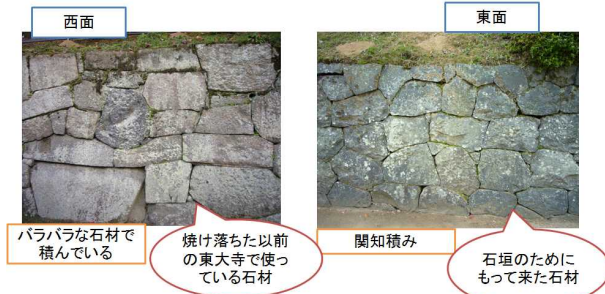
図1 西面と東面の石垣の違い
